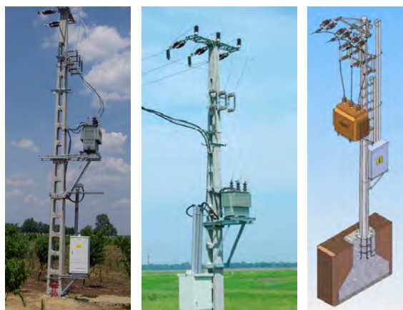
Oszloptranzformátor-állomások
