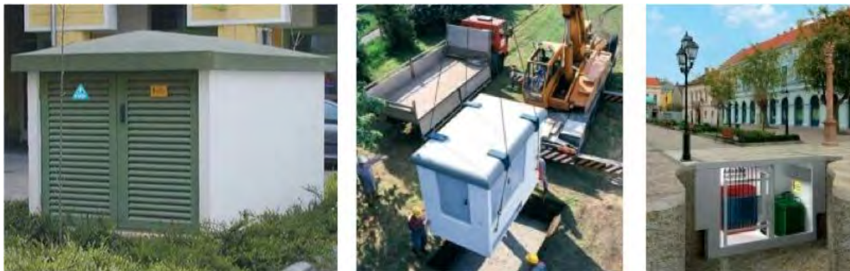
Épületen kívül elhelyezett, előregyártott transzformátorállomások
