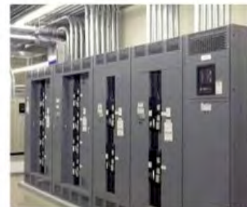
Kis- (a), közepes- (b) és nagyteljesítményű (c) villamos elosztók elrendezése (a: falon, b: falifülkében, c: villamos elosztóhelyiségben)
