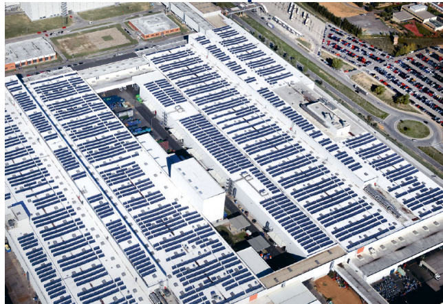
12 MW napelemes rendszer SEAT autógyár, Martorell, Spanyolország
